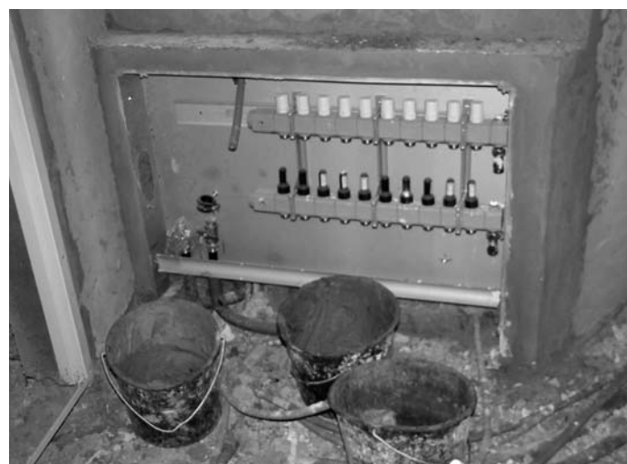
Verteilerkasten für die Fußbodenheizung
